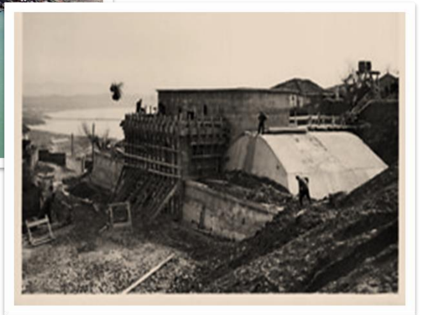
输入管道建造时期的原始照片
